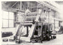
Molenmachine, Hanid en Leng Dusseldort, Molen 30 x 60, inlaatzijde, van de suikertabrick Tjebongan (Fotocollectie Wilton Fjenaar).
